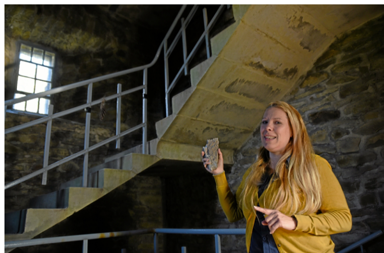
Der Bismarckturm muss saniert werden, Eva Kiermeier vom KIM zeigt ein bereits herabgefallenes Stück Beton.
